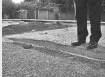
Ilustrasi bagian jalan yang ditinggikan yang terbuat dari beton. Tinggi 10 cm dan lereng sepanjang 1 m untuk kecepatan ideal (30 km/j)
