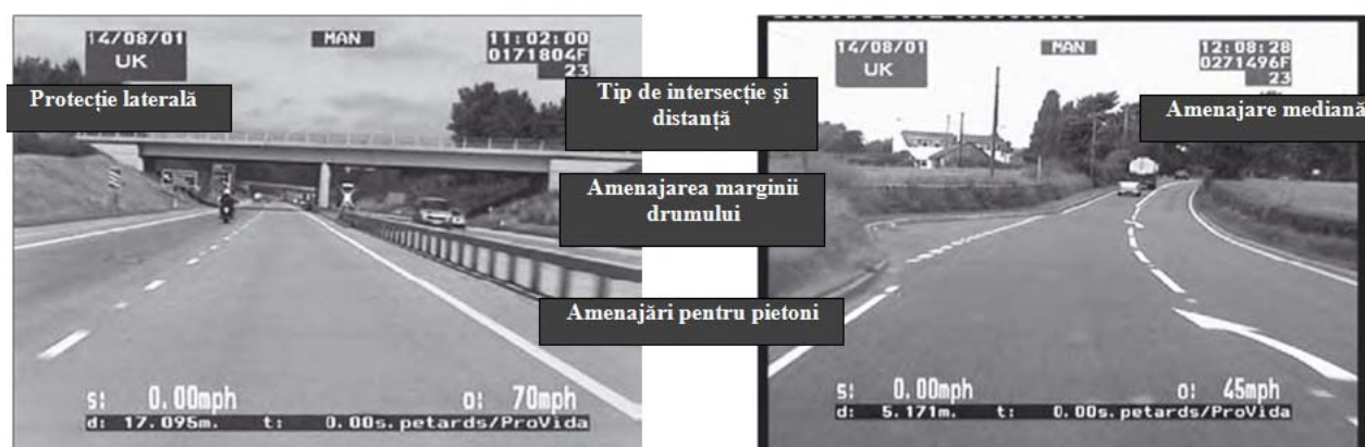
Figura 2 Elemente de proiectare de înalt nivel similare pot fi evaluate pe drumuri de standarde diferite
