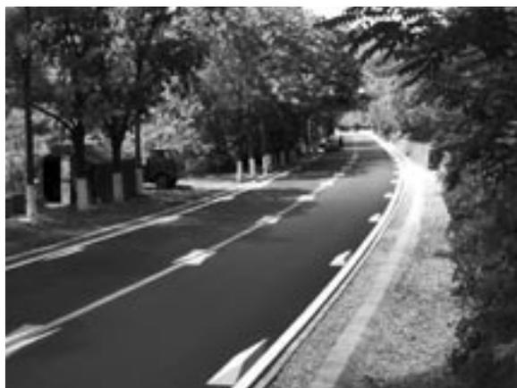
Certains marquages spécialement conçus à cet effet créent une illusion stéréoscopique et donnent aux conducteurs l'impression que la chaussée est plus étroite qu'elle ne l'est en réalité (ce qui les amène automatiquement à ralentir). Ce dispositif a été utilisé à titre expérimental dans plusieurs districts de Chine sur des routes de catégories très diverses.
