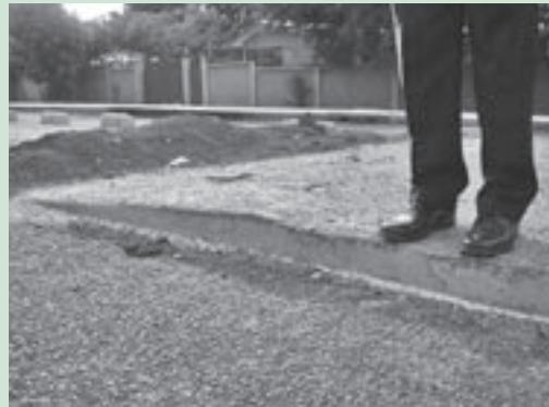
Coupe transversale d'un plateau surélevé en béton de 10 cm de haut munis de deux rampants latéraux de 1 m de long permettant de ramener la vitesse de circulation au niveau souhaité (30 km/h).
