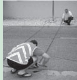
Les boucles à induction sont des câbles intégrés au revêtement goudronné de la chaussée, couplés à un enregistreur de données situé dans un boîtier installé au bord de la route. Les câbles étant enterrés, ils ne subissent pas d'usure liée à la circulation. L'équipement peut fonctionner sans surveillance pendant plusieurs semaines, en fonction de la densité de la circulation et de la capacité de l'enregistreur.
