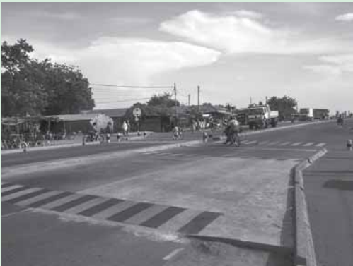
在行人过街斑马线前，中间安全岛两侧交错设置两个梯形减速丘
